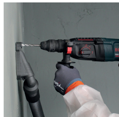
2. Sauger starten, Löcher bohren
